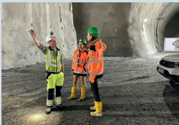
Gesandte Barbara Schedler Fischer (Mitte) und Verkehrsreferentin Michaela Landauer (rechts) werden im Brenner Basistunnel über den Fortschritt der Arbeiten informiert.
