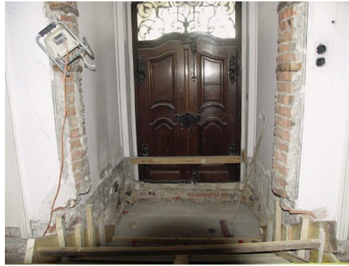
Holztür im Eingangsbereich
